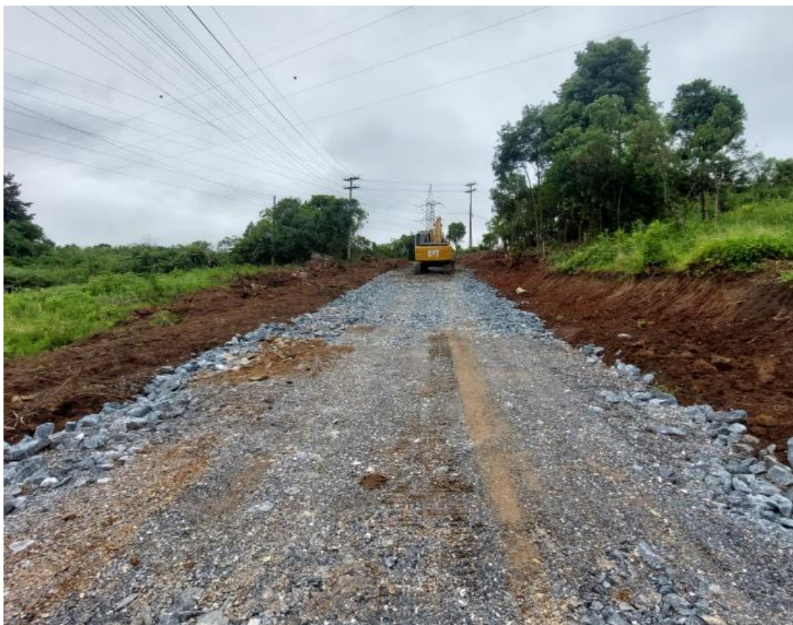
Imagem 2 – abertura da via. Execução através da Secretaria Municipal de Obras Públicas.
